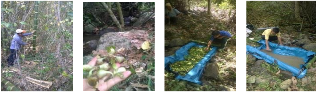
Figura 2. Secuencia de la construcción del biosistema o humedal artificial.
