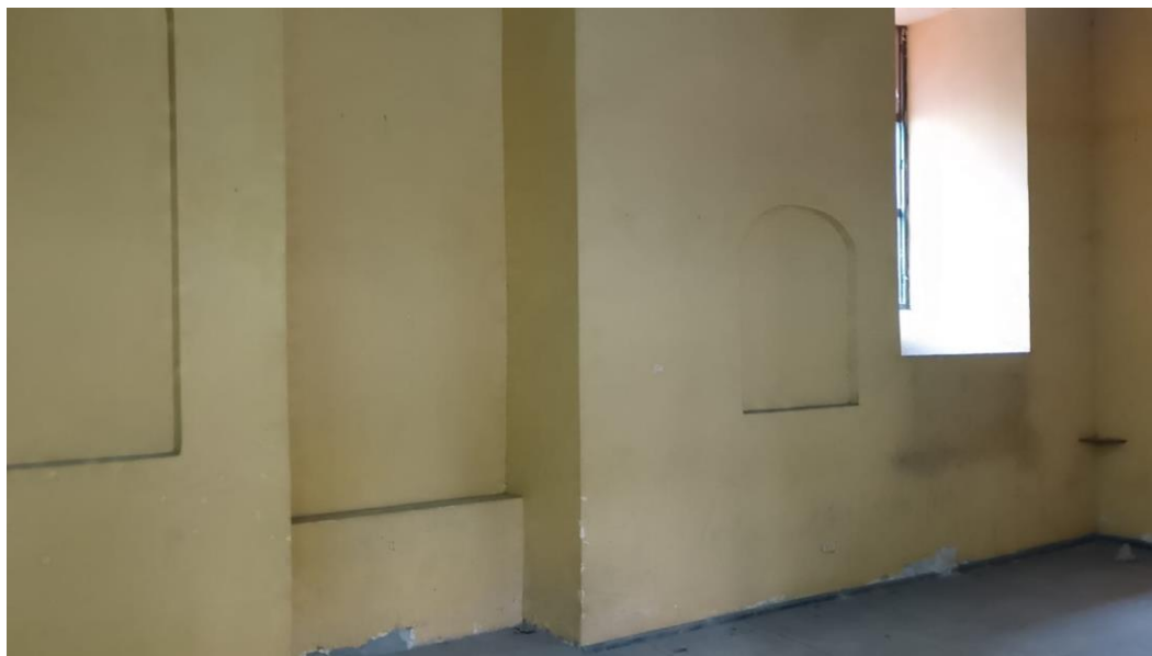
Figura 7. Ambiente de un aula de la primera planta que pertenece al colegio San Juan del centro histórico de Trujillo.
